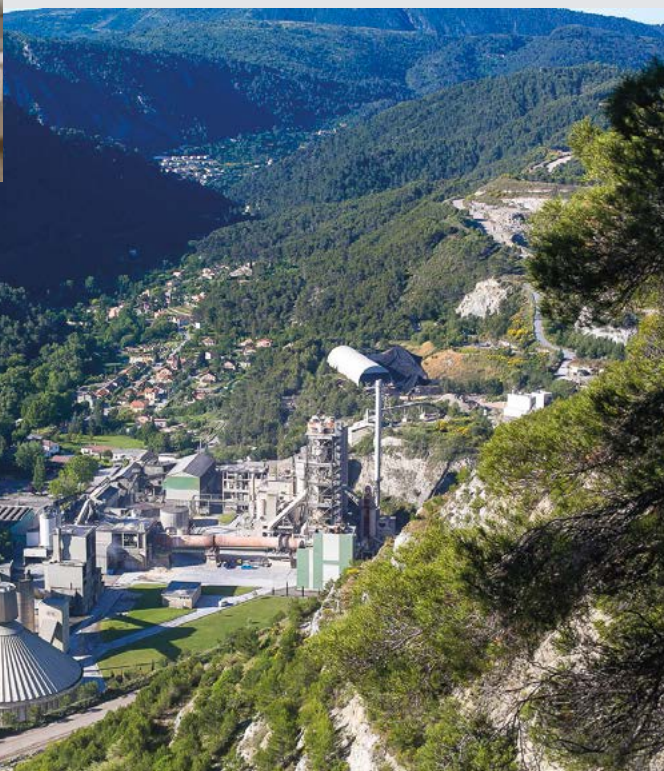
▼ La Grave de Peille cement plant (France)
