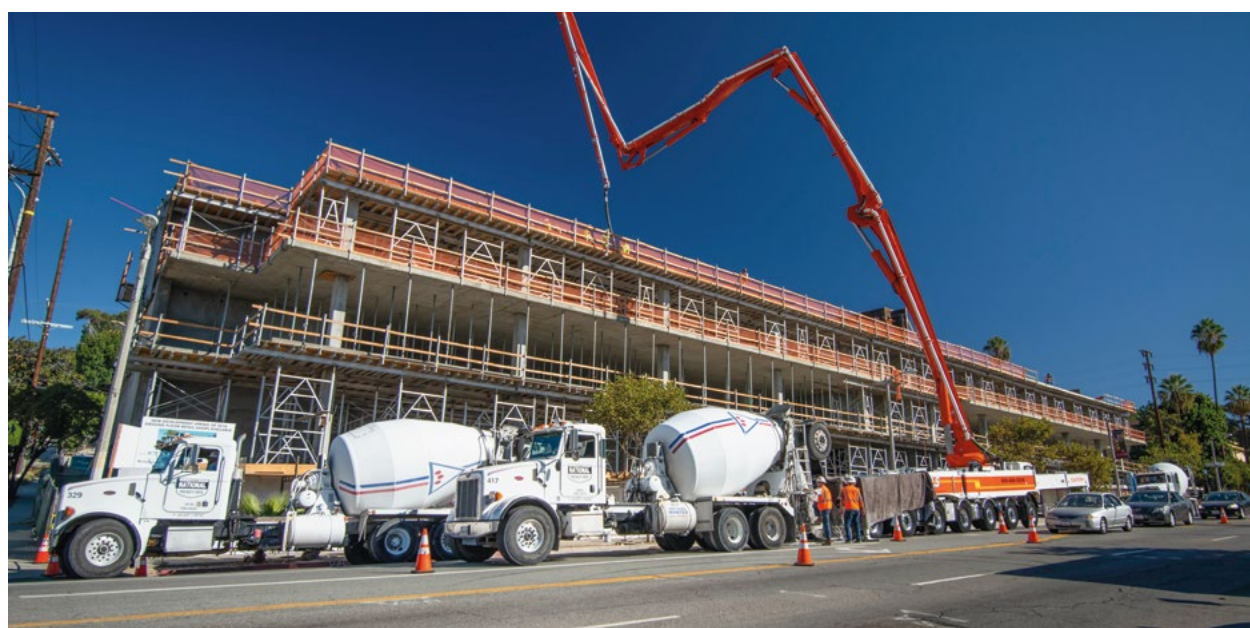
• Chantier du parking couvert de Broadway, Los Angeles (États-Unis).
