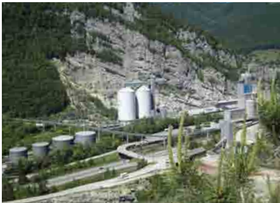
▲ The Reuchenette plant.
